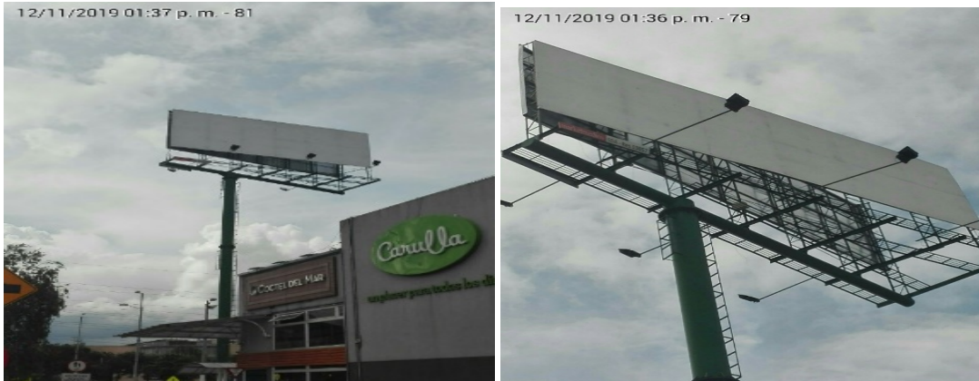
Foto No.1 y 2: Vista panorámica del predio, del panel y de la estructura de la valla, ubicada en la Av. Carrera 45 No. 183A-86 (dirección registrada) y/o Avenida 13 No. 184-00 (dirección catastral), orientación Este-Oeste .
